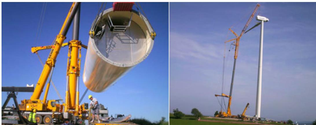
*Figure 33: illustration de la phase de montage. La grue utilisée permet de limiter l'emprise au sol.*
