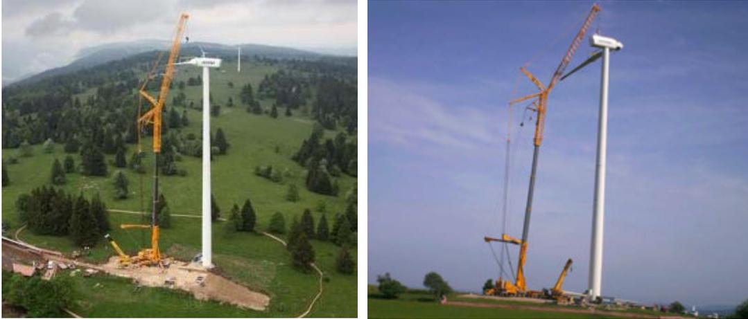
*Figure 31: dernières étapes de montage des pales, illustration de la dimension d'une plateforme avec la grue de montage.*
